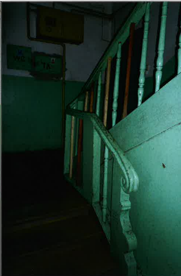
fragment klatki schodowej na parterze;
