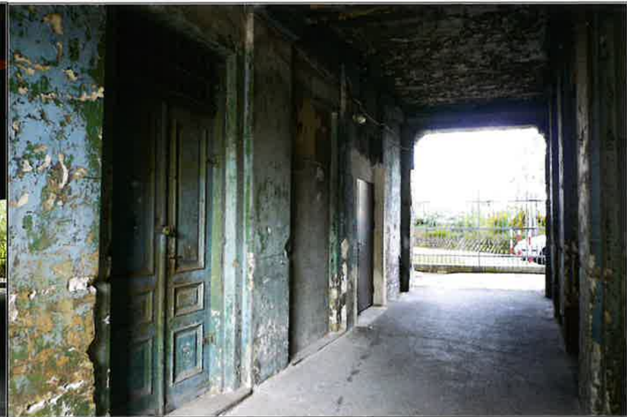
Wnętrze przejazdu bramnego (widok w kierunku podwórza).
