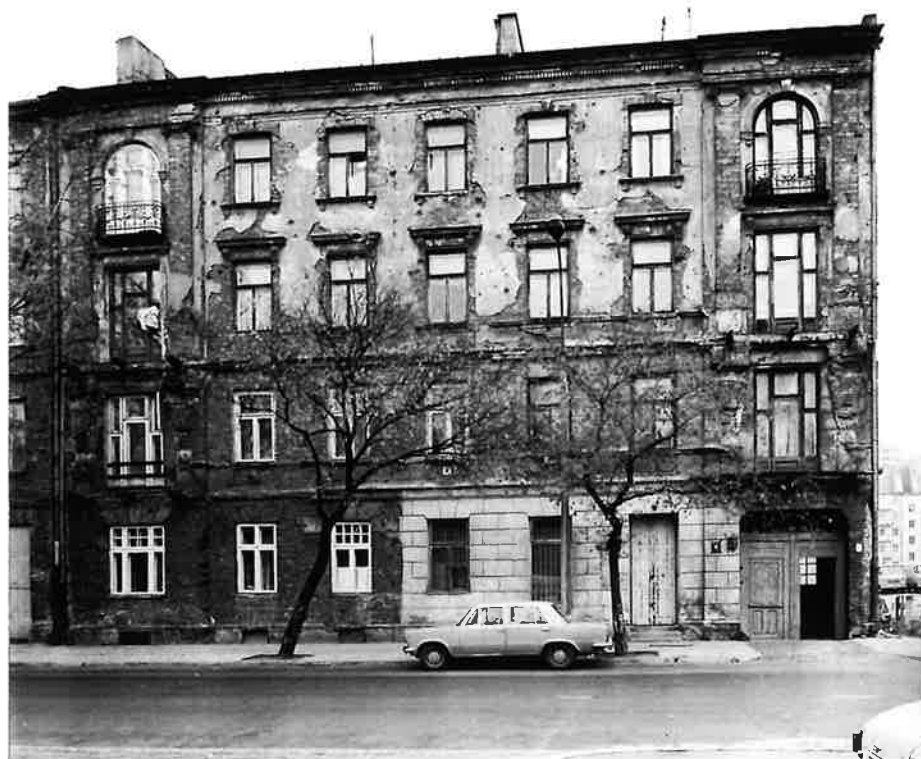
Elewacja frontowa, stan koniec lat 70 XX w.
