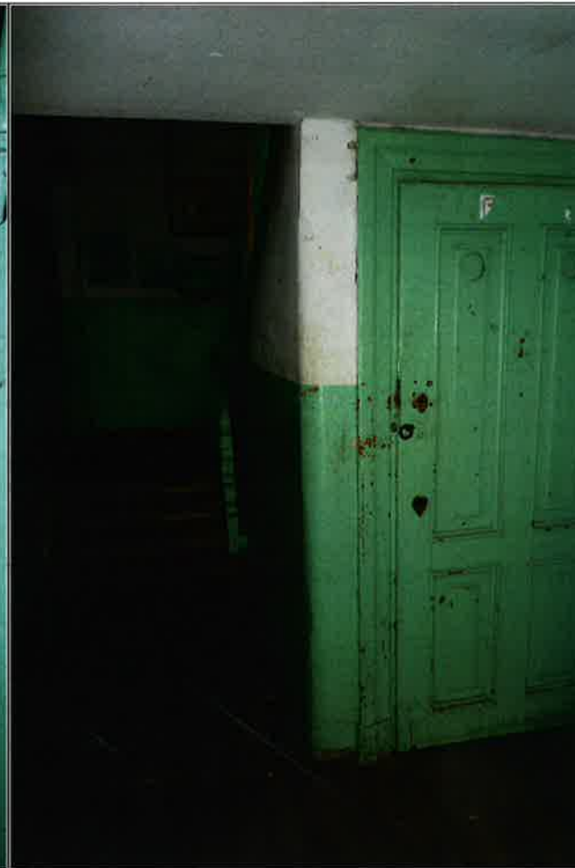
widok na klatkę schodową od strony wejścia podwórza.
