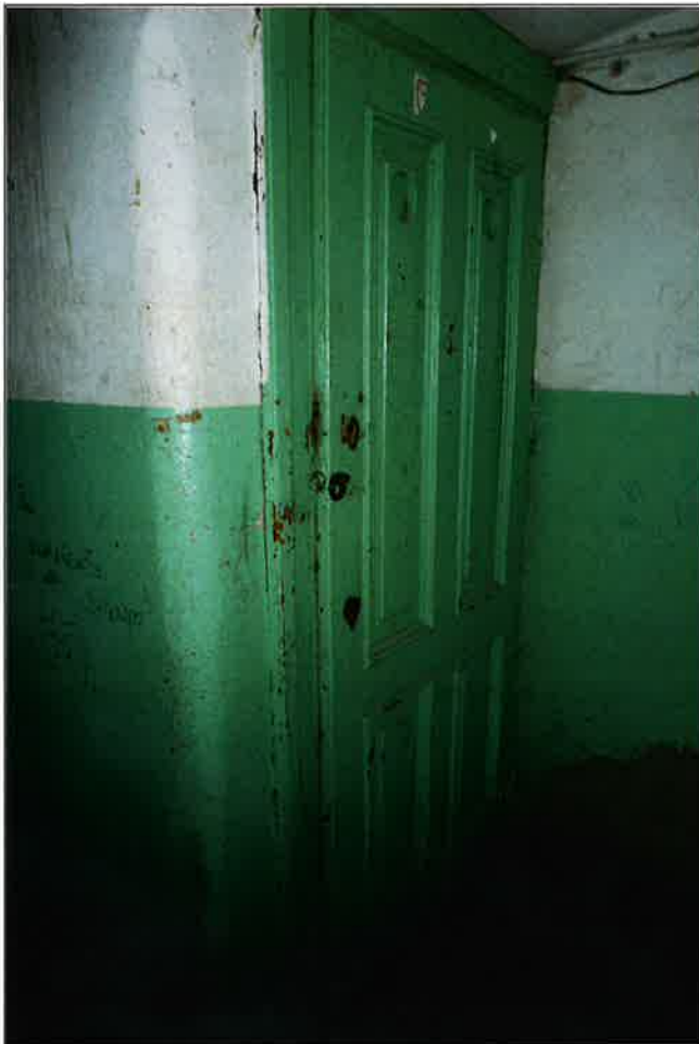
Drzwi prowadzące do piwnicy;
