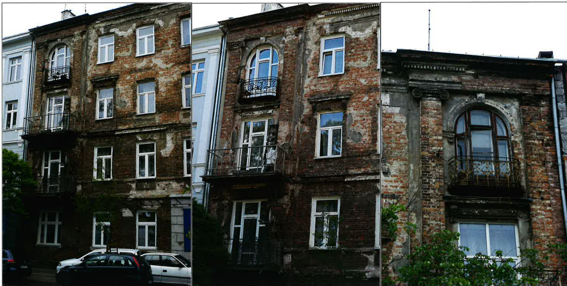
Południowa część elewacji frontowej.
