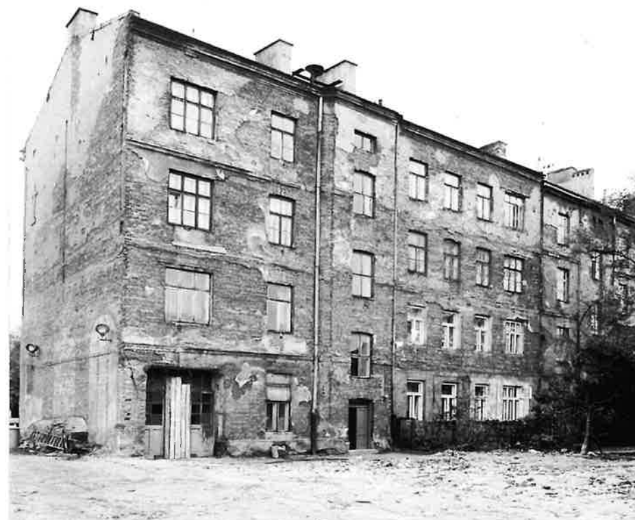
Elewacja tylna, stan koniec lat 70 XX w.
