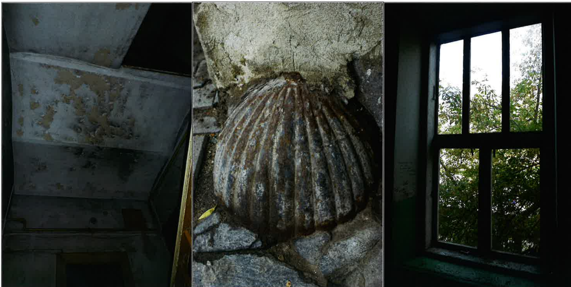
Żeliwny odbojnik w przejeździe bramnym.
