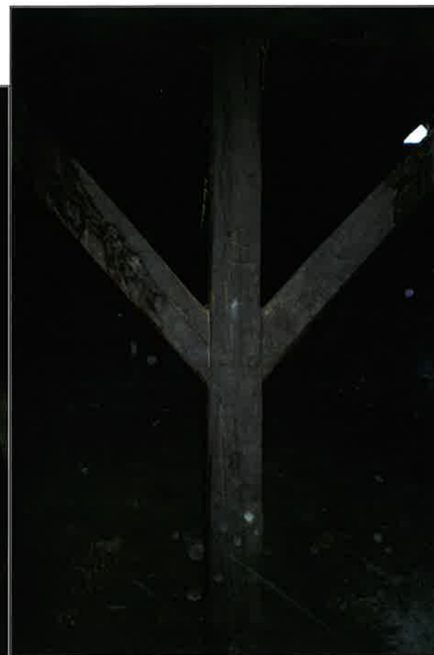
słup więźby dachowej z zastrzałami(widoczne znaki ciesielskie).
