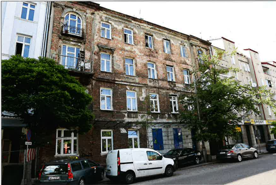
Widok ogólny elewacji frontowej od strony zachodniej.
