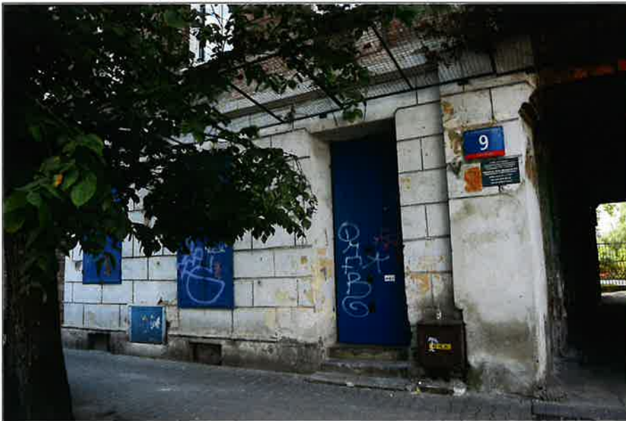
Lokal usługowy przy przejeździe bramnym w elewacji frontowej.
